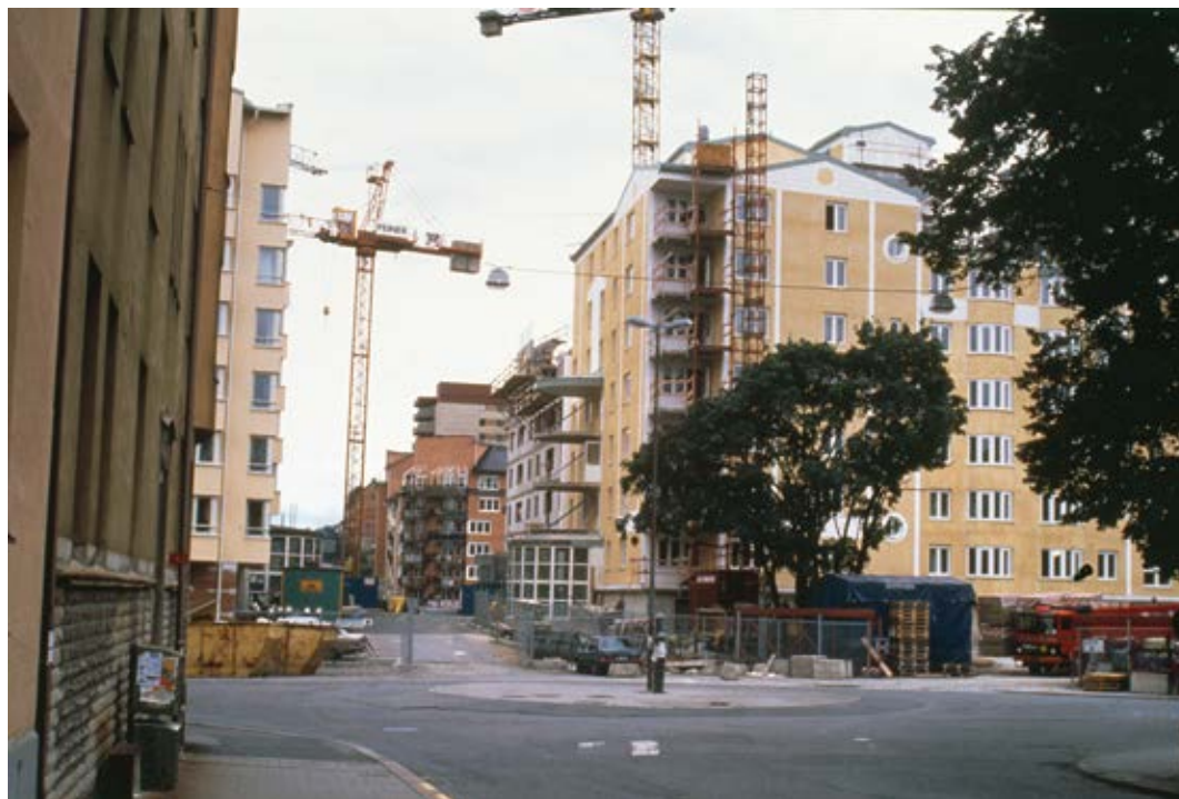
Flerfamiljshus i post-modernistisk stil under byggnation i Södra Stationsområdet i Stockholm 1988. Husen är djupa och fönstren små med stora spröjs i metall.
