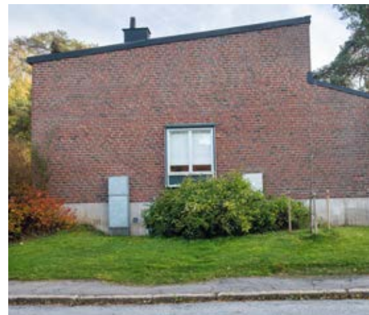
Husens fasadmateriäl är flera. Långornas kortsidor är av tegel och betong, medan långornas ytterväggar även har spritputs och eternit.
